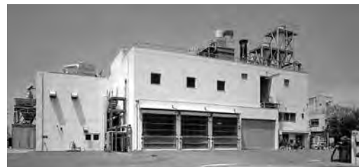
廃水処理プラント
