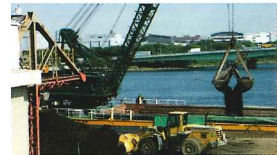
▲当社機械より汚染土壌を船積作業中の船舶
