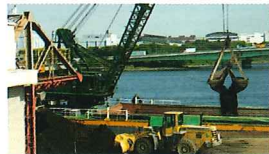
▲当社仕様より汚染土壌を船積作業中の船舶
