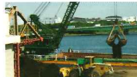
▲当社桟橋より汚染土壌を船積作業中の船舶
