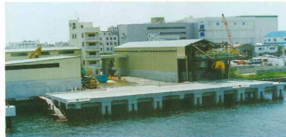
▲重量トン数1,600トンクラスの船舶が接岸可能な当社桟橋
