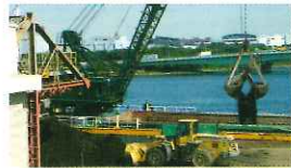
▲当社棧橋より汚染土壌を船積作業中の船舶
