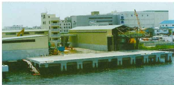
▲重さトン数1,500トンクラスの船舶が接岸可能な当社設備
