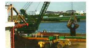
▲当社機橋より汚染土壌を船積作業中の船舶
